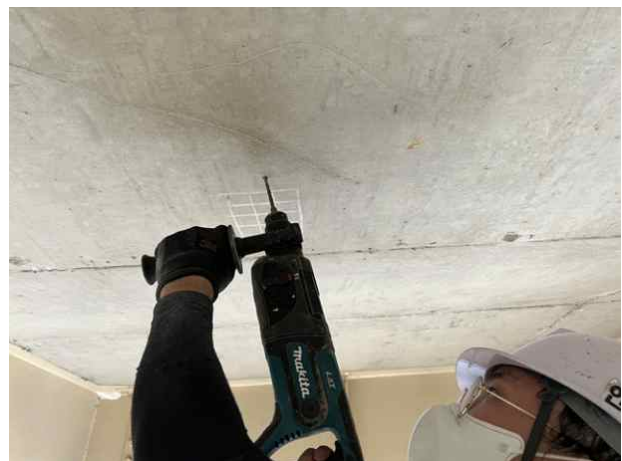
탄산화깊이 측정 현황
